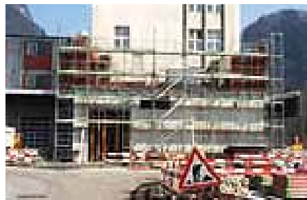
Das 6 m hohe erste Stockwerk beanspruchte viel Zeit.
