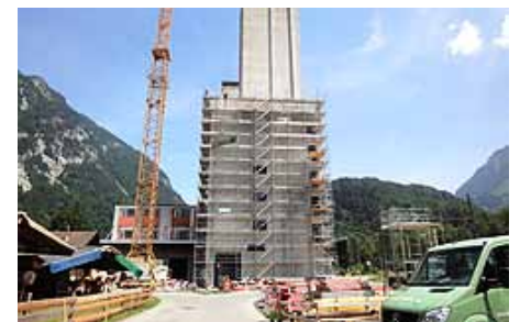
Ein zweckmässiger Anbau, welcher sich ideal an den bestehenden Bau anpasst.
